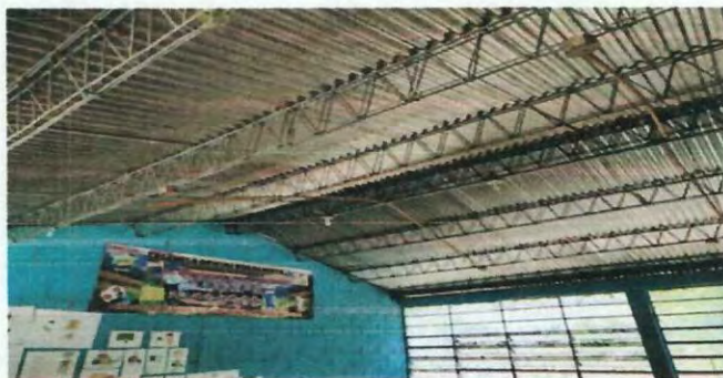
Foto 3: Se puede observar la estructura portante del modulo de las aulas y dirección.
