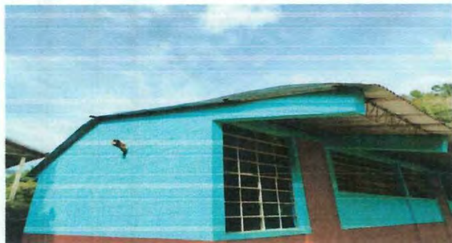
Foto 1: Se puede observar el deterioro de las láminas portantes de las aulas y dirección.
